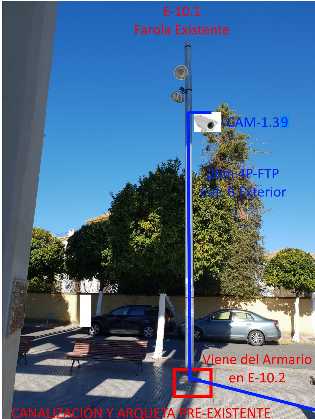
E-10.1: Simulación y Fotomontaje de las Cámaras y equipamiento del emplazamiento exterior.
