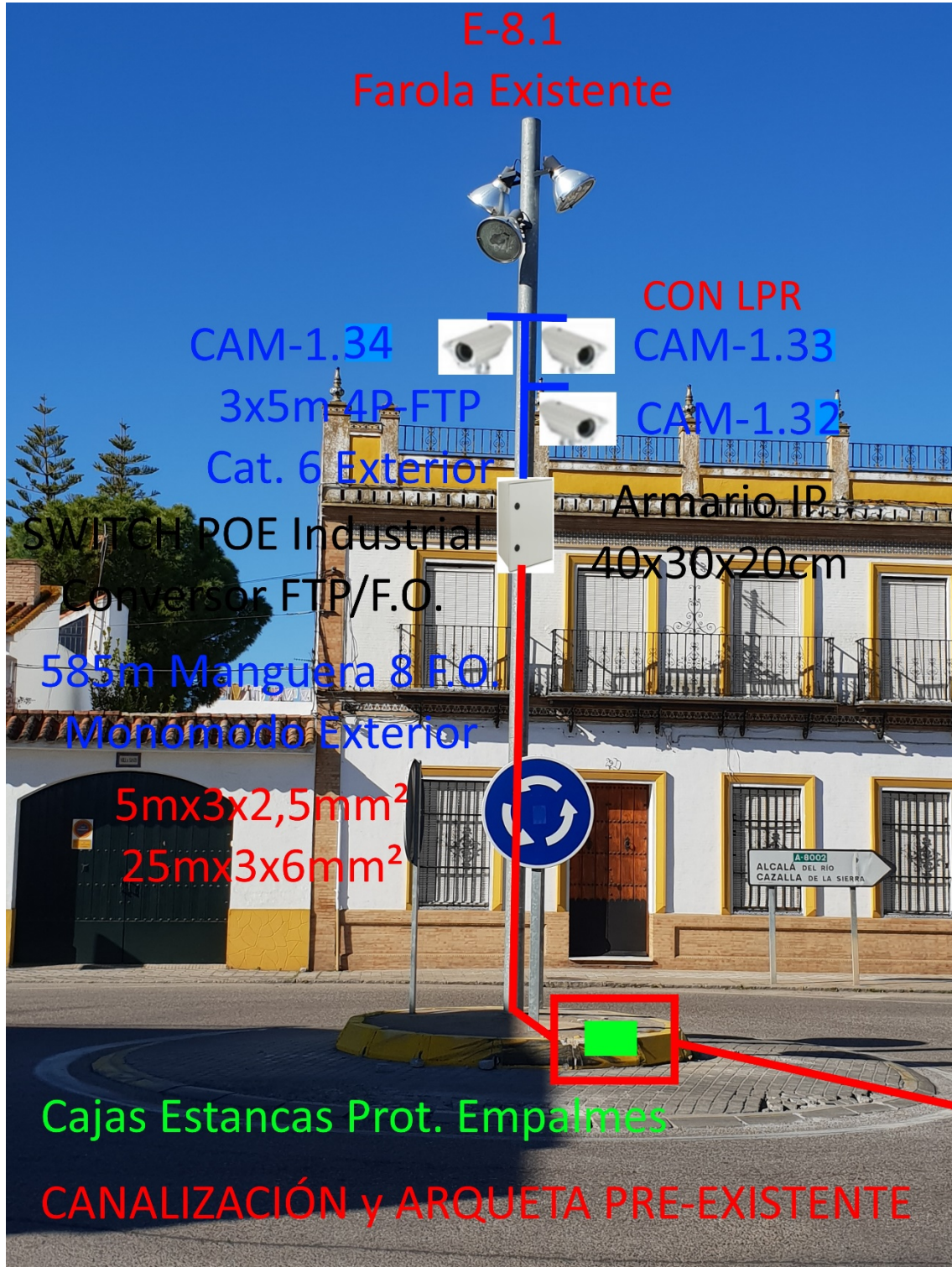
E-8.1: Simulación y Fotomontaje de las Cámaras y equipamiento del emplazamiento exterior. y CON LICENCIA LPR PARA LECTURA DE MATRÍCULAS
