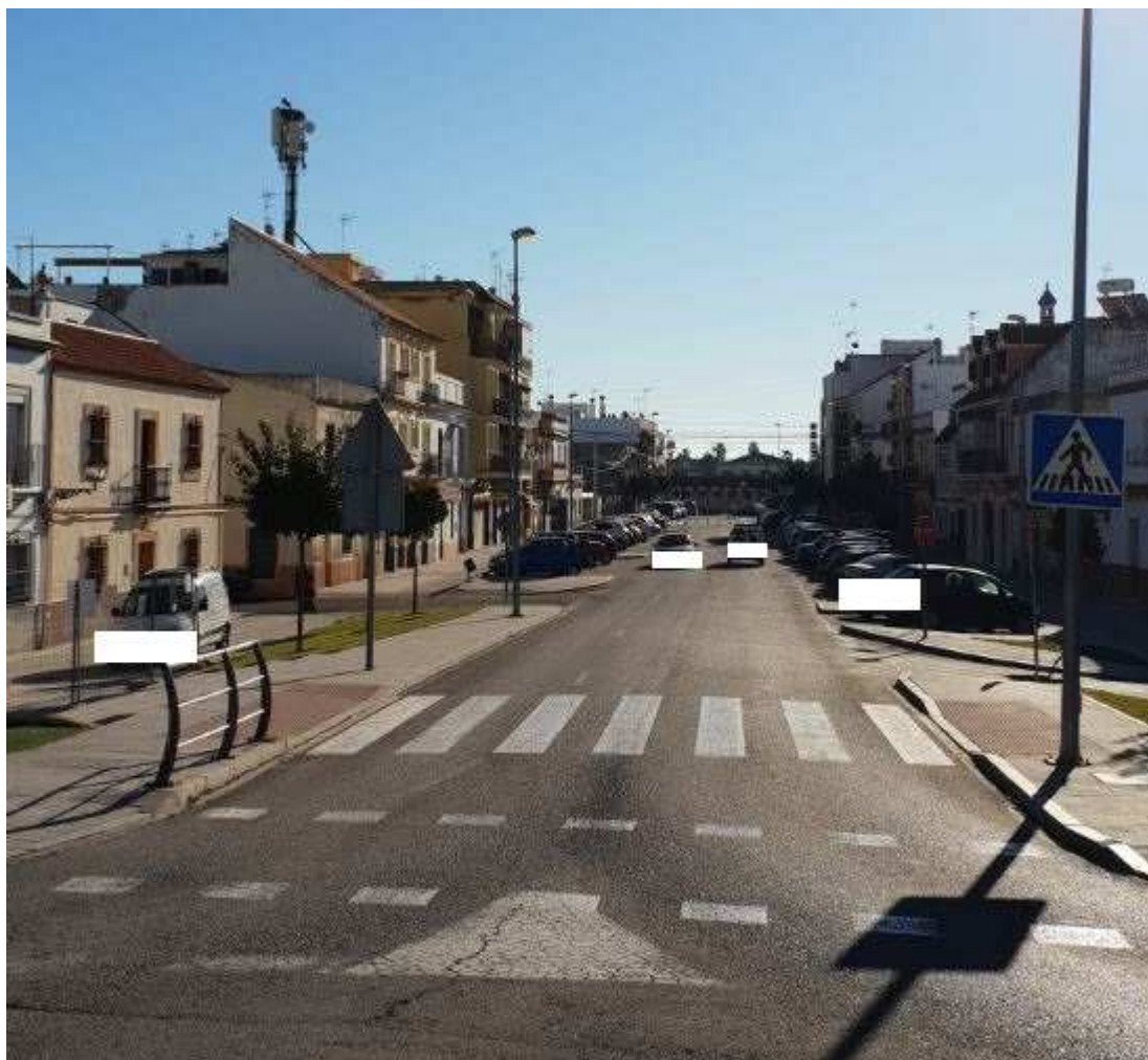
CAM-1.05 en E-2.1, Azimut 114°: Cobertura hacia Calle San José SURESTE
