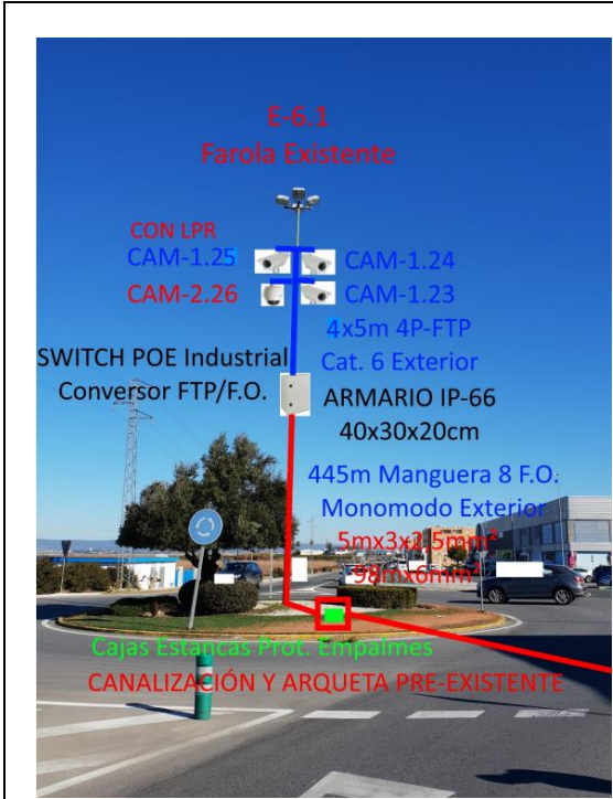
EMPLAZAMIENTO 6.1: ANTES DE LA INSTALACIÓN
