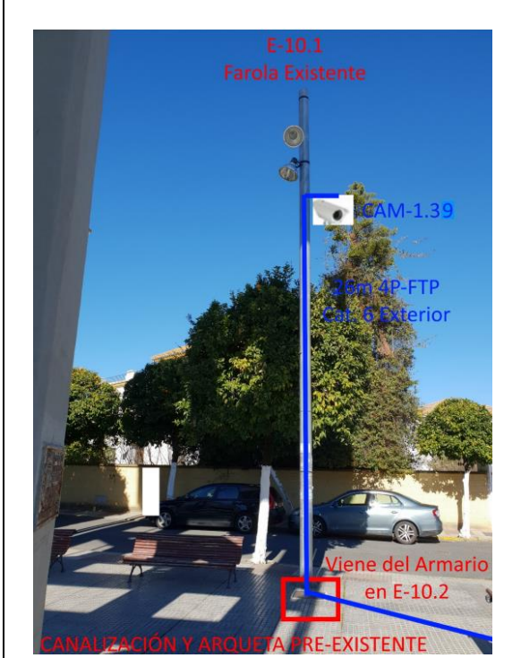
EMPLAZAMIENTO 10.1: ANTES DE LA INSTALACIÓN
