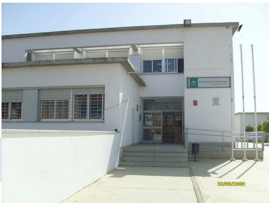
Vista de la entrada principal del edificio.
