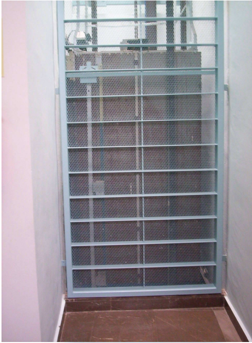
Recorrido de las tres paradas del ascensor protegido mediante estructura metálica.
