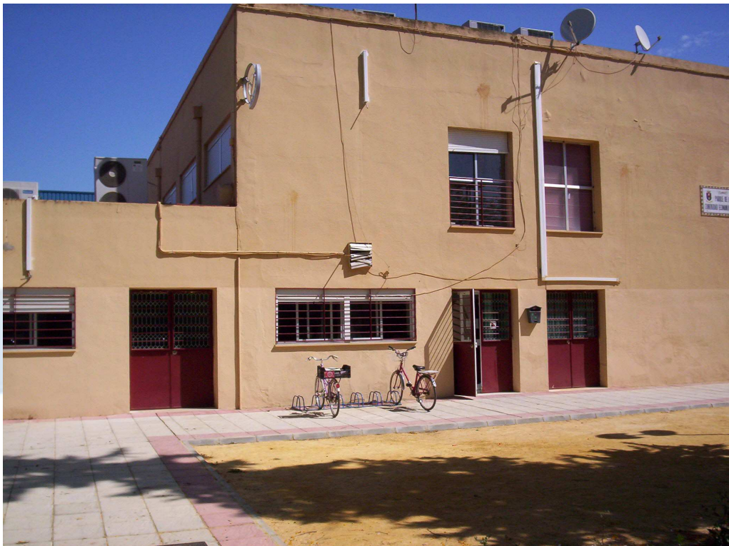
Vista de entrada principal al edificio conjunto de Servicios Sociales y Hogar del Pensionista.
