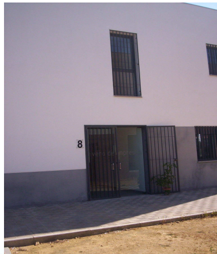
Puerta de entrada principal.
