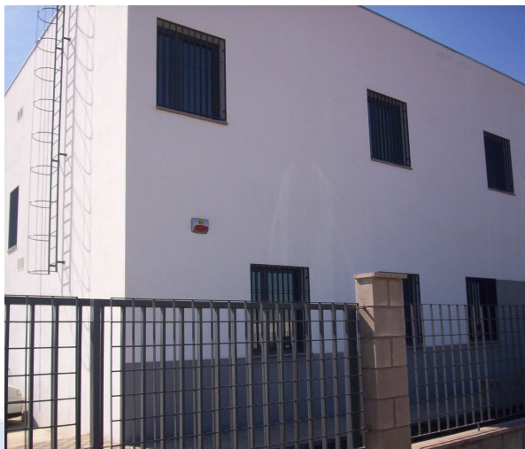
Vista exterior del edificio del Vivero de Empresas.
