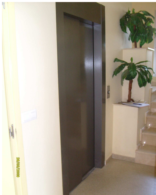
Vista diagonal del ascensor en estado parado.
