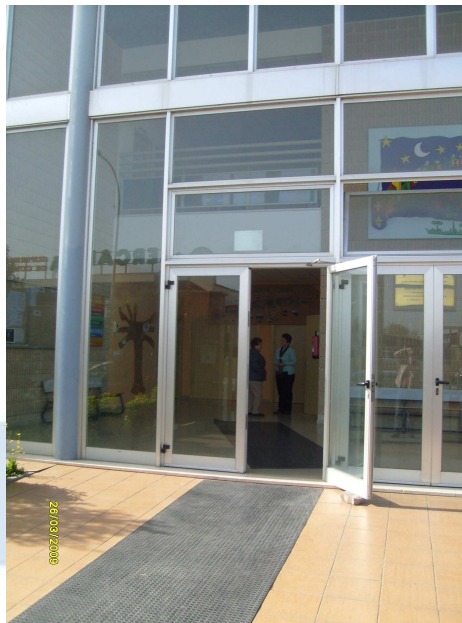
Vista de la entrada principal de acceso al edificio.
