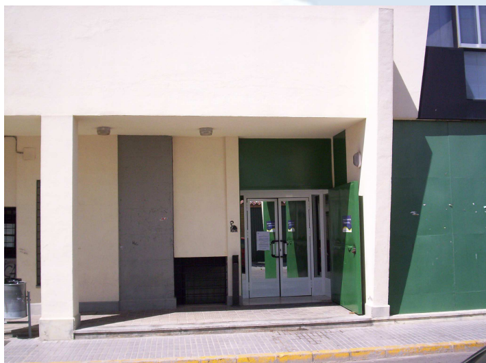
Vista frontal a la altura de la puerta principal.
