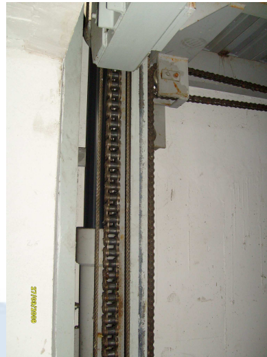
Sistema de cadenas y engranajes.
