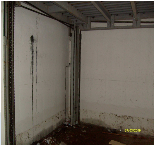
Vista subterránea del montacargas.
