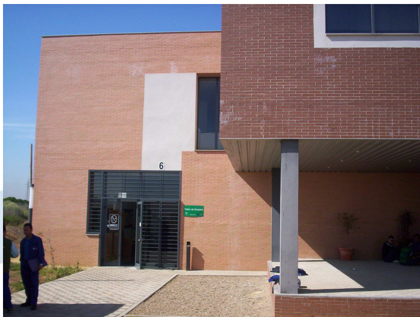
Entrada principal del Edificio Centro de Formación Cáñamo II.
